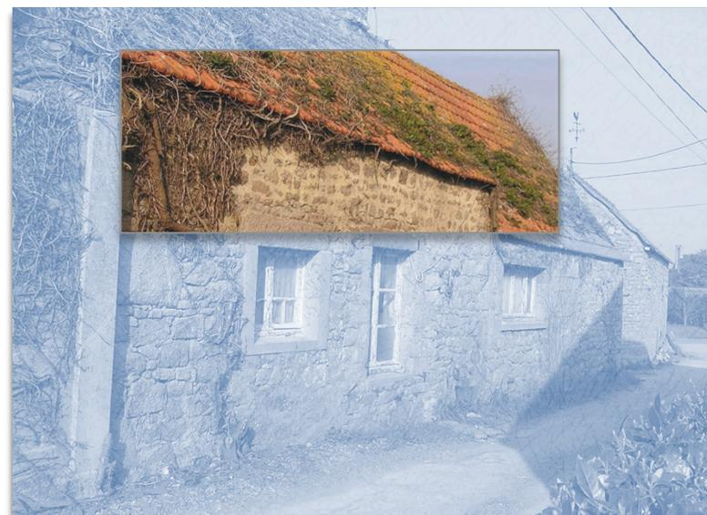
**Le mauvais entretien de la couverture entraîne une dégradation rapide de l'édifice. Il est nécessaire de contrôler l'étanchéité de la toiture et de veiller à l'état du matériau de couverture.**
